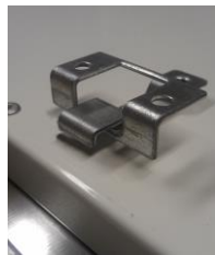
Detail eingehängte Deckenhalter
