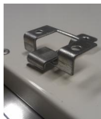
Detail eingehängte Deckenhalter
