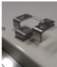
Detail eingehängte Deckenhalter
