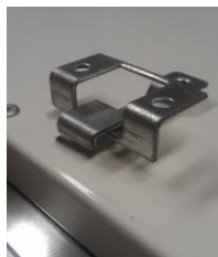
Detail eingehängte Deckenhalter
