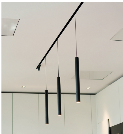
Bild 3: Die bündig integrierten Infrarot-Heizelemente von Vitramo fallen kaum auf und liefern angenehme Strahlungswärme
