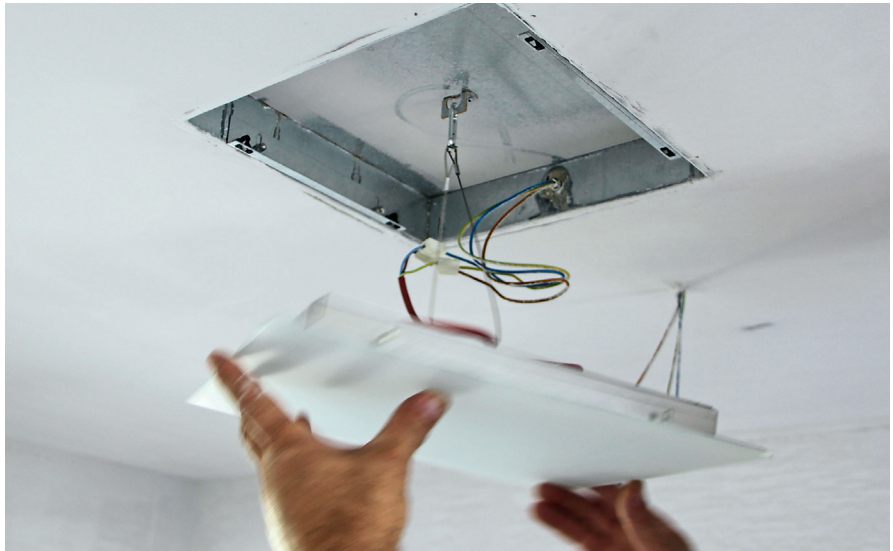
Bild 6: Für ein Infrarot-Heizelement wird das Einbauehäuse aus verzinktem Blech und das Anschlusskabel in die Betondecke eingebracht
